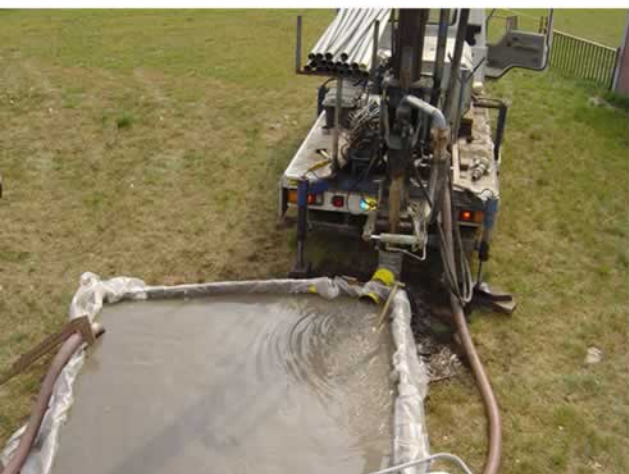
(Foto: boorstelling in werking)
